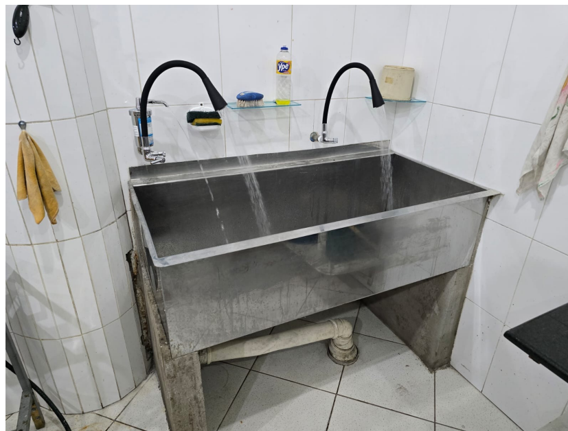
Instalado torneiras e filtro água potável
