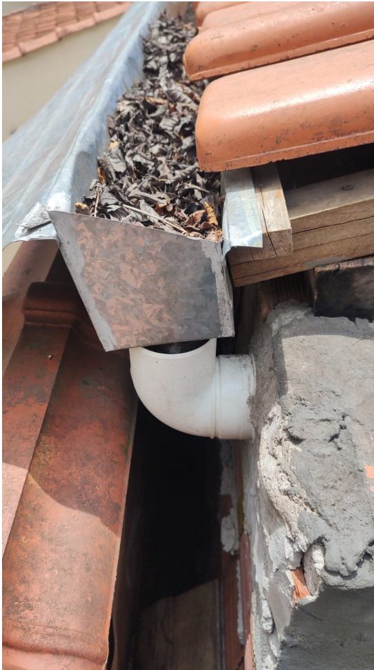
Limpeza das calhas
